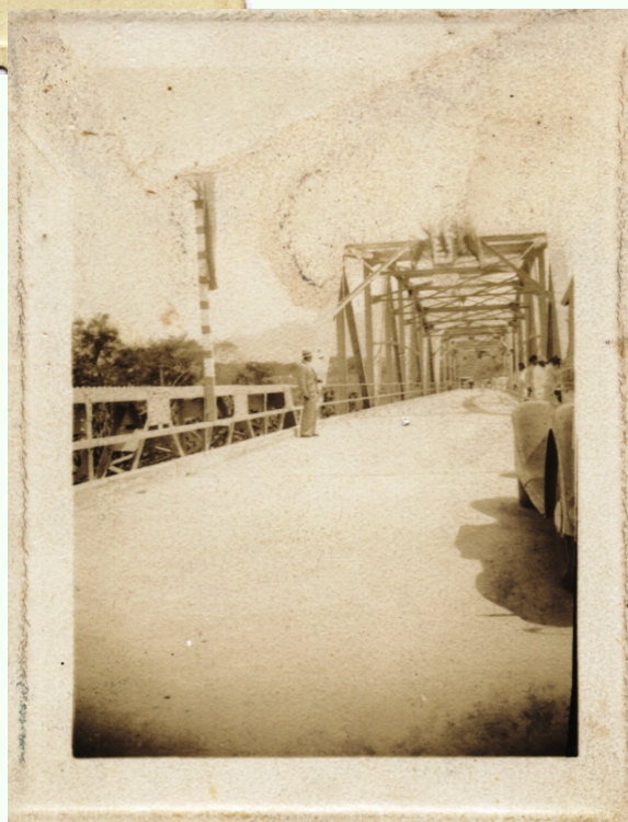
Vistas de la Inauguración del Puente Sobre el río Tuy en Ocumare, Año 1937, fotos de Manuel Vicente Monasterios Fonseca.
